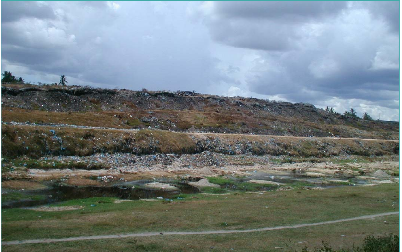
Demonstration project on the application of vetiver grass for erosion and leachate control at a landfill site in Dar es Salaam, Tanzania Le projet de démonstration sur l'application d'herbe de vétiver pour le contrôle de l'érosion et du lixiviat dans une décharge publique de Dar es-Salaam en Tanzanie
