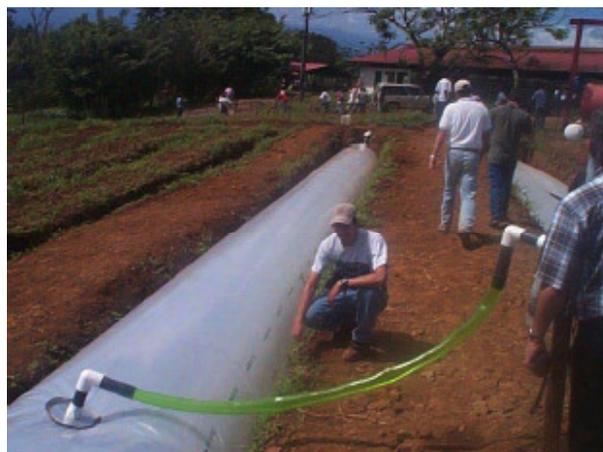
Biodigestor con manguera para
